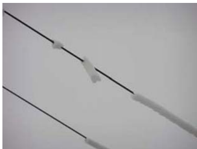
Figuur 2.6 Ijsvorming aan fasedraden
